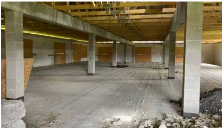
Pohľad do podstrešného priestoru
