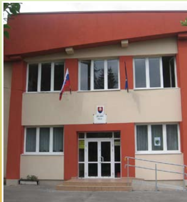
Základná škola po rekonštrukcii
