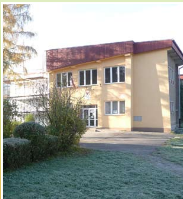
Základná škola pred rekonštrukciou
